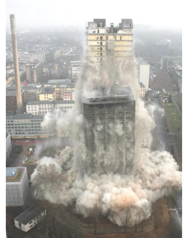
Sprengung des AFE-Hochhauses in Frankfurt a. M. Reisch Sprengtechnik GmbH
