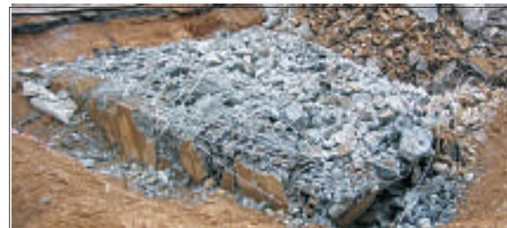
Wesseling, Sprengung eines Fundamentes Richard Liesegang GmbH & Co.KG
