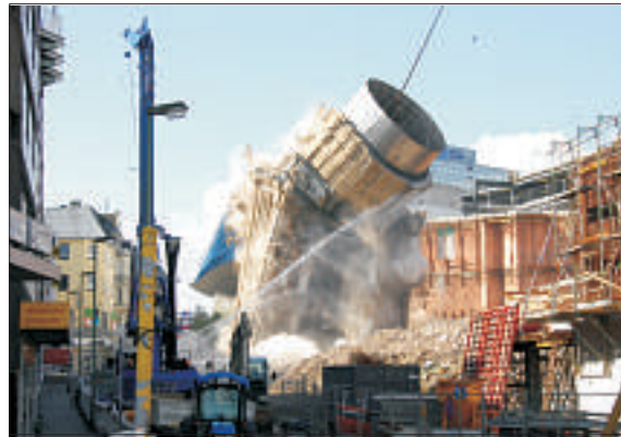
Essen, Sprengung Eckturm am Limbecker Platz Roller Sprengtechnik GmbH
