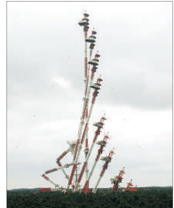
Frohnau, Sprengung eines 365 m hohen Sendemastes - Thüringer Sprenggesellschaft mbH
