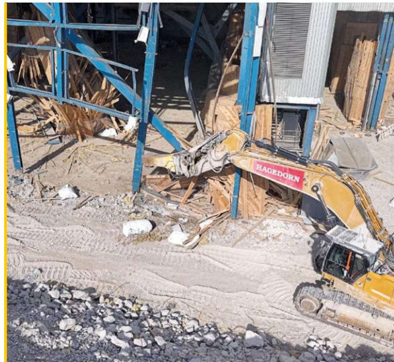
Abschlagen der Schrauben an den Stahlstützen mit Cat Command ferngesteuertem Hydraulikhammer (an Cat 395)
