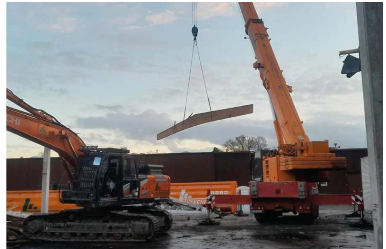
Insgesamt 20 Holzleimbinder wurden sorgfältig ausgebaut und mit Hilfe eines Krans abgehoben.
