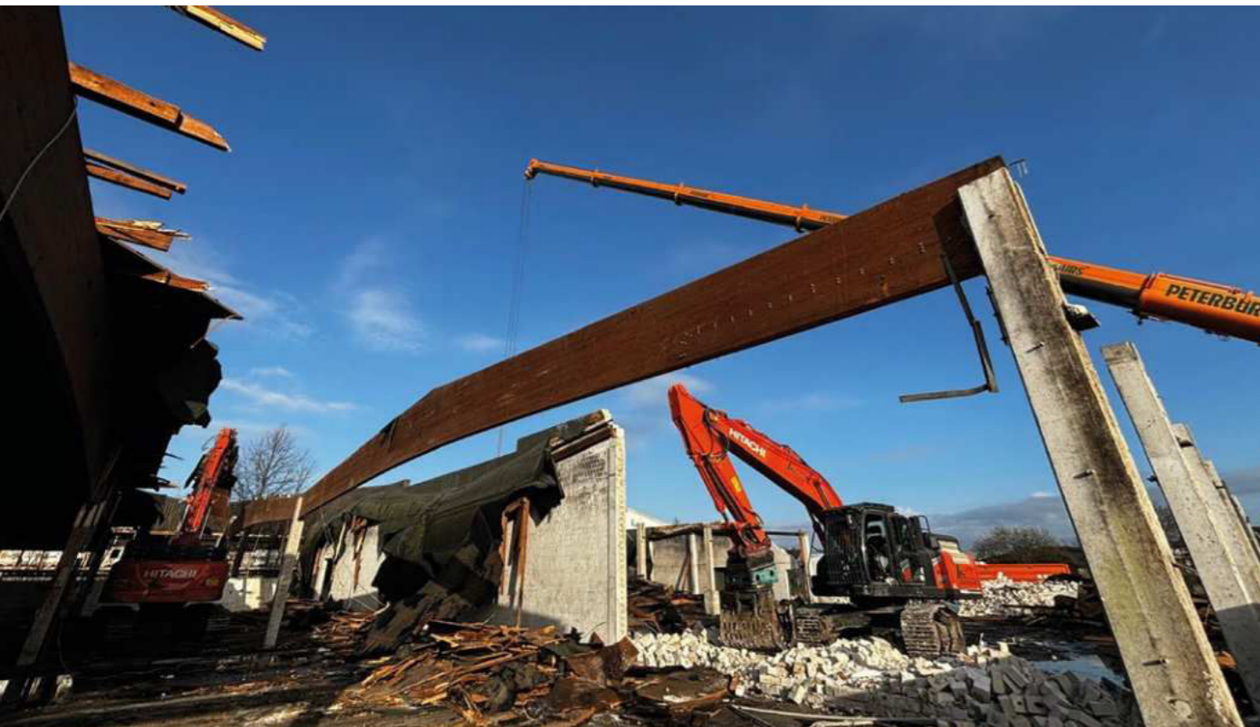
Bagger sorgen in Rheda-Wiedenbrück für den selektiven Rückbau einer alten Möbelfabrik.
