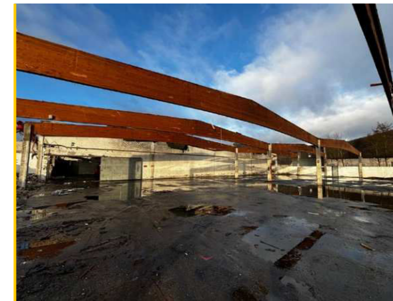
Noch gut erhalten: Die Holzleimbinder eigneten sich bestens für den Ausbau und die Wiederverwendung.
