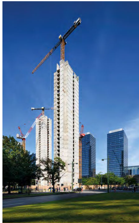
Das Ergebnis der Rückbauarbeiten: die Kerne der ehemaligen WTC-Türme | Foto: © photo-daylight.com
