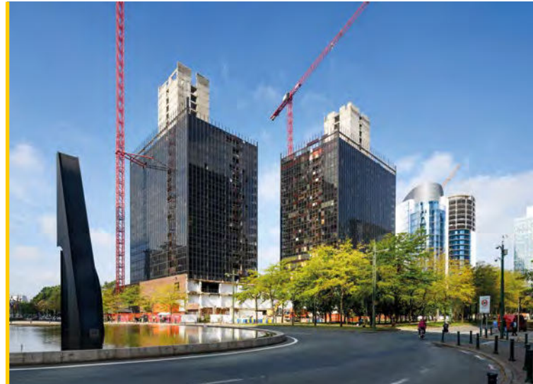
Für die Umnutzung wurden die beiden Türme des WTC Brüssel teilweise abgebrochen. | Foto: © photo-daylight.com
