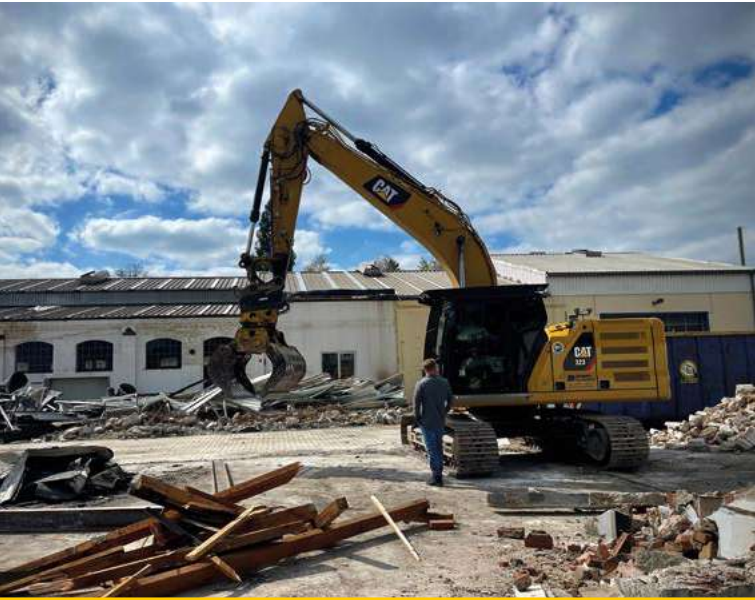
Firma Schröder bricht derzeit eine Fertigungshalle eines Delmenhorster Maschinenbauunternehmens ab
