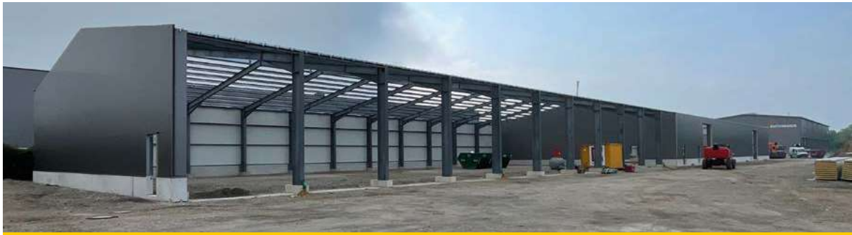
Die neue Halle ist fast fertig
