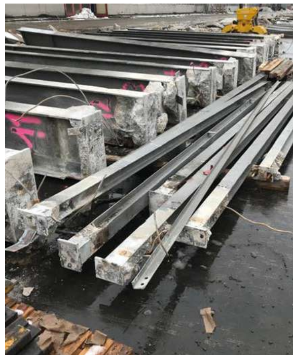
Bis ins Kleinste wurde die Halle zerlegt
