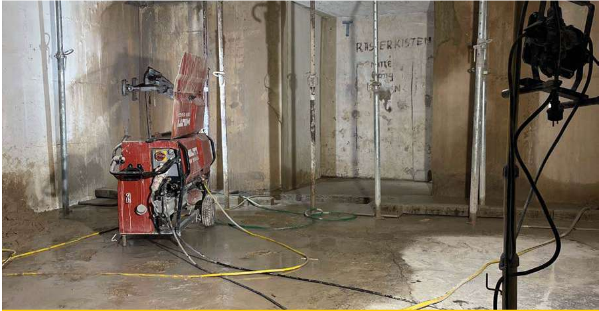
Mit einer Diamantseilsäge wird eine Scheibe aus der Mauer geschnitten
